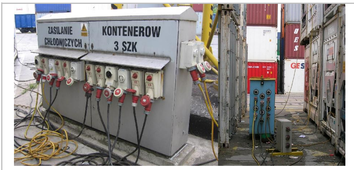
Rys. 7. Przykłady stanowisk do zasilania kontenerów chłodniczych [zdjęcia własne]
