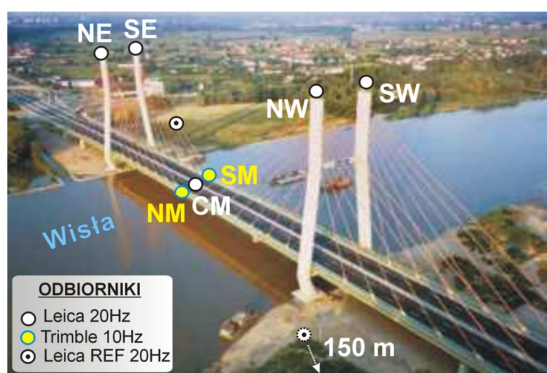
Rys. 3. Rozmieszczenie odbiorników na wybranych elementach konstrukcji
