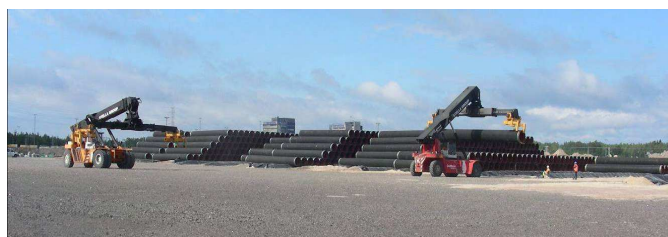
Rys. 4. Przykład jednego z magazynów rur (Kotka)
