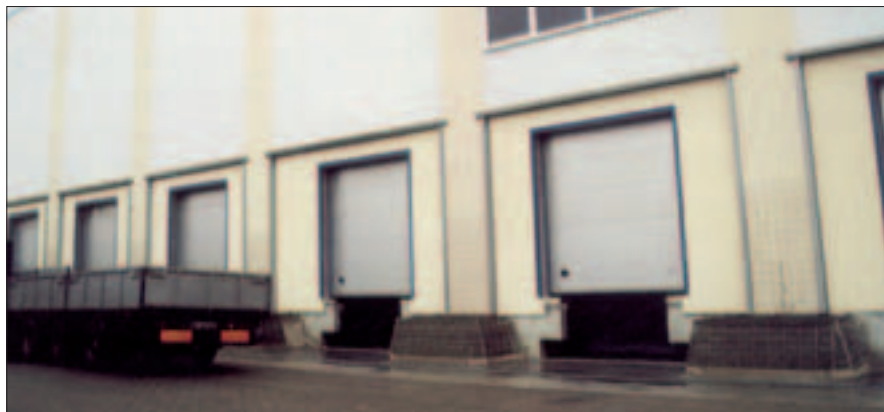
Rys. 1. Magazyn z bezrampowym frontem przeładunkowym, posiadający stanowiska przeładunkowe, rozlokowane bezpośrednio w bramach obiektu. Źródło: Materiały informacyjne producenta
