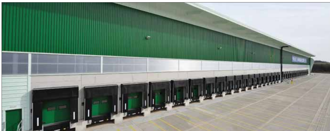
Fot. 4. Fragment południowej elewacji CL G. Blue Planet z płytami kinetycznymi (fot. Gazeley).
