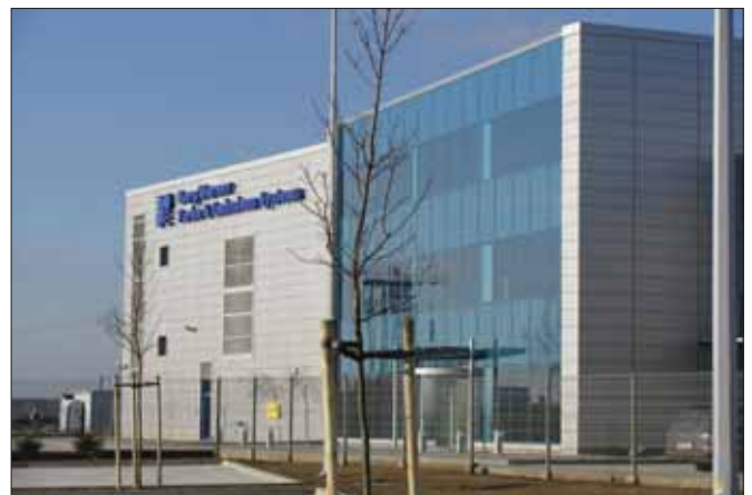
Fot. 2. Obiekt biurowo – produkcyjny BorgWarner Turbo Systems Poland Sp. z o.o., Rzeszów – pierwszy w Polsce budynek z certyfikatem LEED na poziomie silver w wersji 2.2.; konsultant LEED – VvS | Architects & Consultants. Źródło: BorgWarner.
