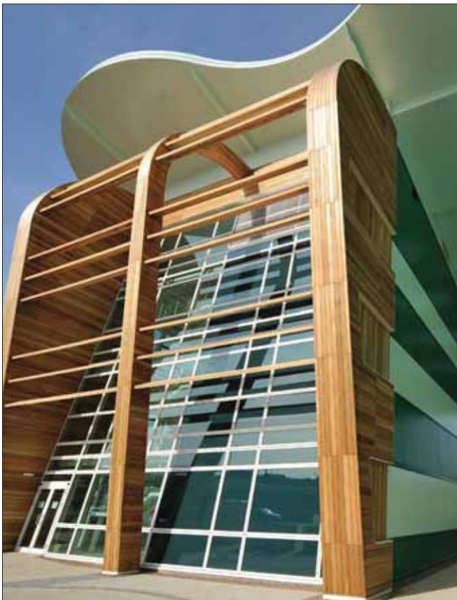
Fot. 5. Wejście do części biurowej CL G. Blue Planet (fot. Gazeley).
