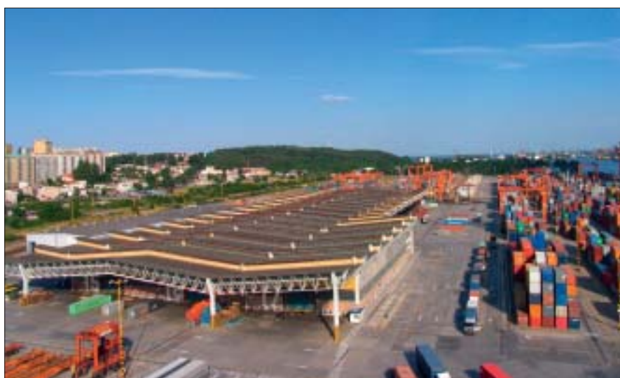
Fot. 2. Magazyn zbiorczo – rozdzielczy i fragment placu składowego na Bałtyckim Terminalu Kontenerowym (fot. T.Urbaniak).
