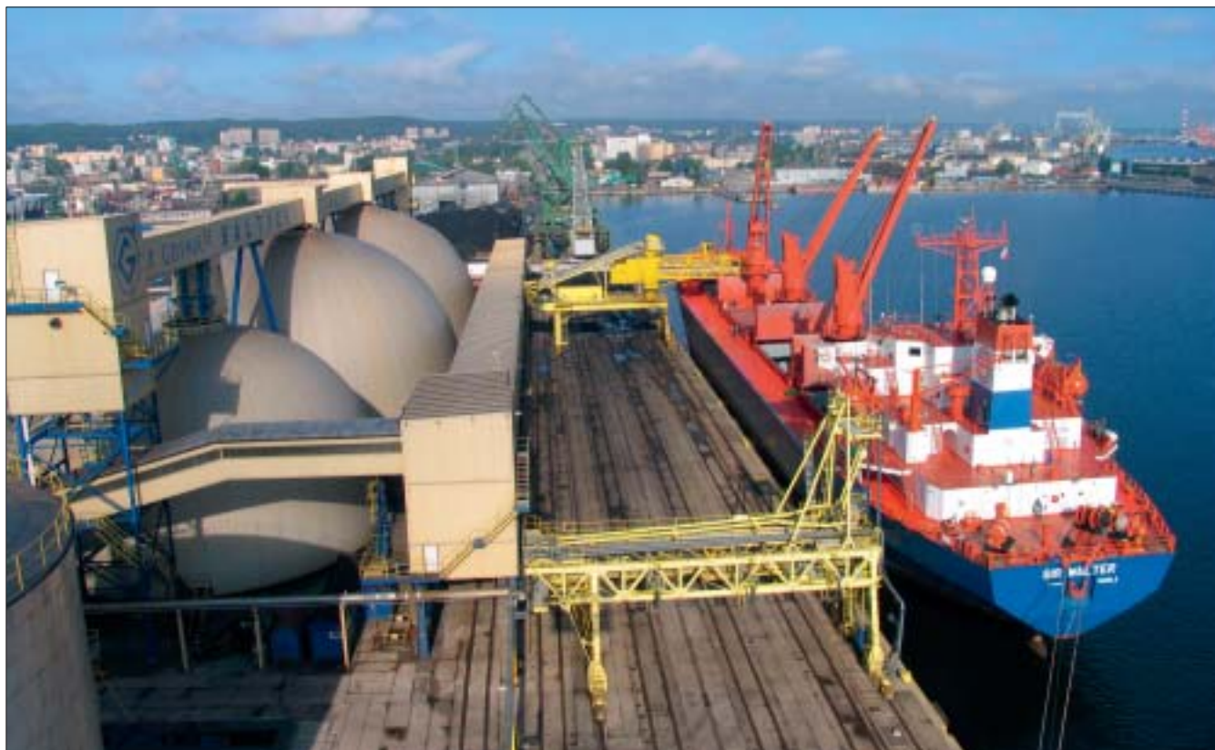
Fot. 5. Silosy kopułowe na ładunki masowe suche na Terminalu Masowym w Gdyni (fot. T.Urbaniak).
