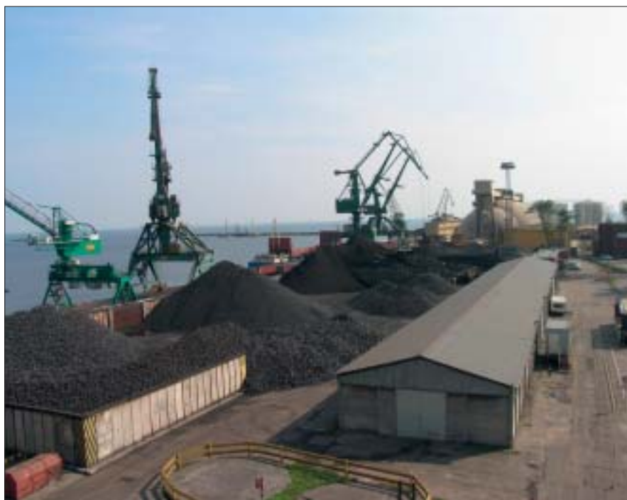
Fot. 6. Zasobnie na ładunki masowe sypkie (fot. T.Urbaniak).
