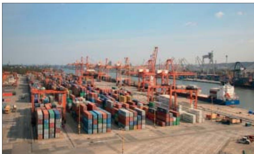
Fot. 3. Plac składowy na Bałtyckim Terminalu Kontenerowym (fot. T.Urbaniak).
