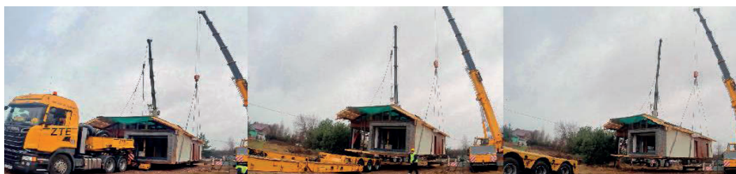
Rys. 9. Etapy rozładunku domu modelowego Źródło: ZTE Sp. z o.o. Sp.K.
