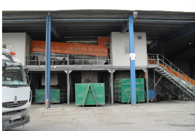
Fot. 1. Hala nr 5 do obróbki odpadów zmieszanych cz. 1. Źródło: materiały z firmy RIPOK.
