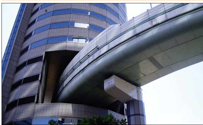
Fot. 5. Fragment autostrady przebiegającej przez Gate Tower. Źródło: [4].
