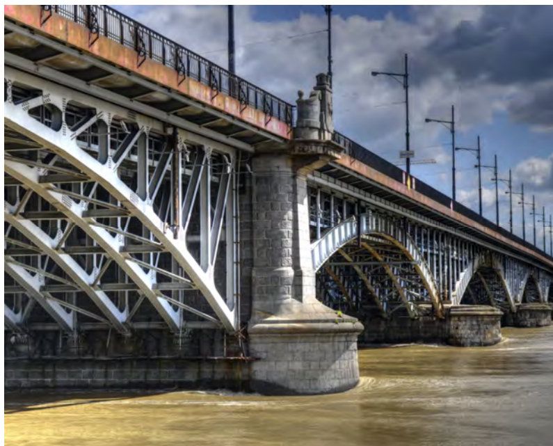
Fot. 2. Most miejski (fot. A. Marecki 2009)
