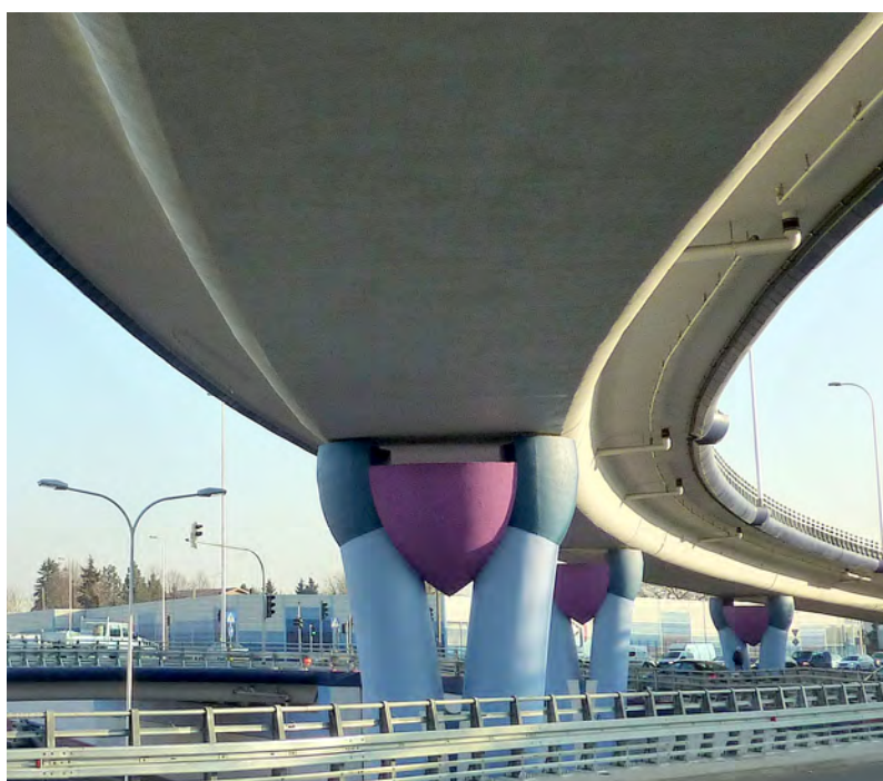
Fot. 1. Estakada miejska (fot. A. Marecki 2012)
