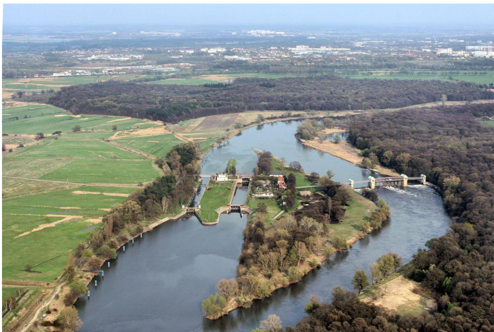
Rys. 18. Widok na śluzy i jaz Rędzin przed rozpoczęciem budowy Autostradowej Obwodnicy Wrocławia – przed 2008 rokiem [2]
