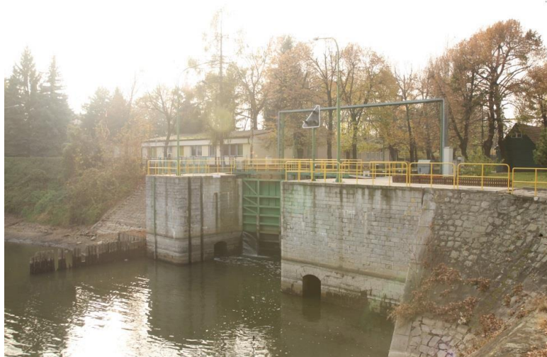
Rys. 6. Widok na Śluzę Szczytniki od strony wody dolnej. Źródło: własne [listopad 2013]
