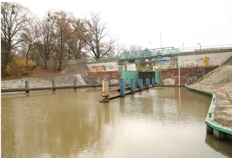
Rys. 15. Widok na kierownice awanportu Śluzy Bartoszowice od strony wody dolnej. Źródło: własne [XI 2013]
