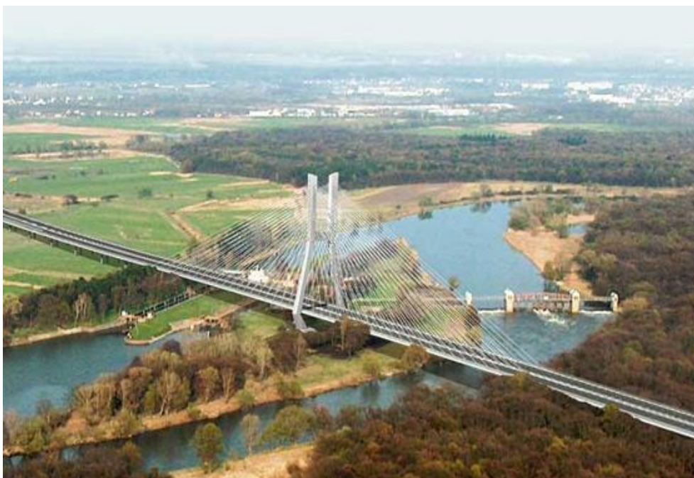
Rys. 19. Widok na śluzy i jaz Rędzin po budowie obwodnicy Wrocławia [8]
