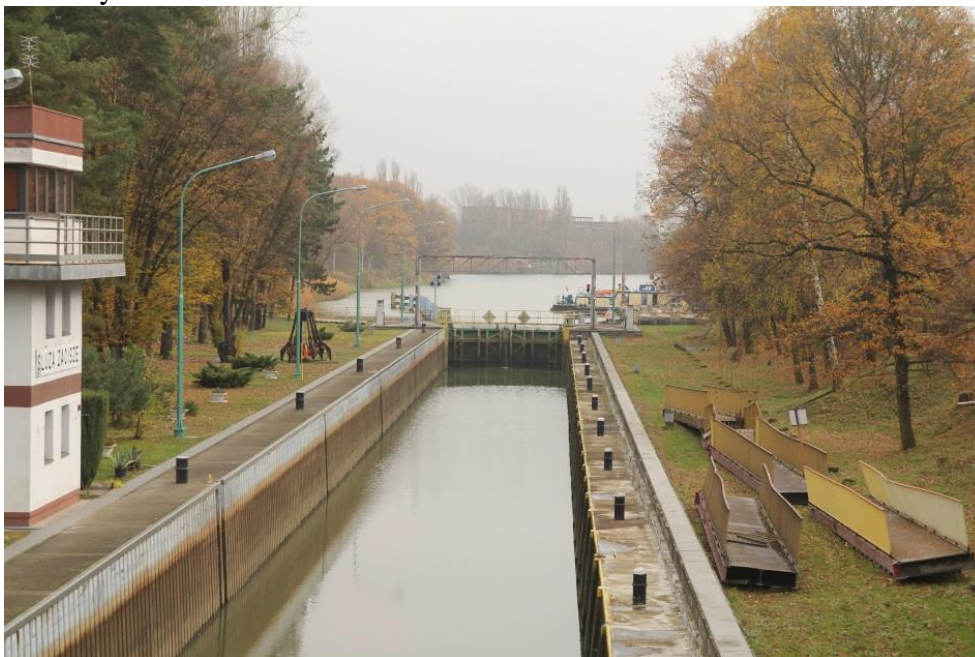
Rys. 16. Widok na komorę Śluzy Zacisze wraz z budynkiem sterowni. Źródło: własne [listopad 2013]
