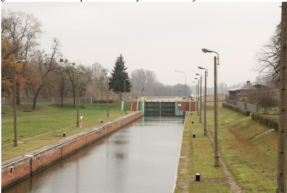
Rys. 14. Widok na komorę Śluzy Bartoszowice. Źródło: własne [listopad 2013]
