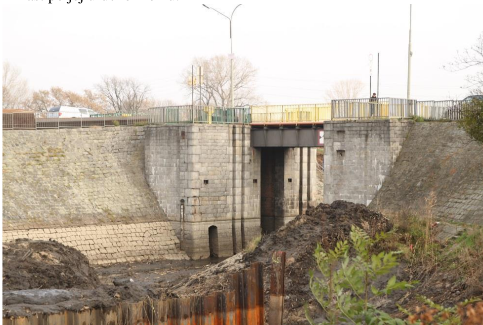
Rys. 8 Brama Przeciwpowodziowa. Źródło: własne [listopad 2013]
