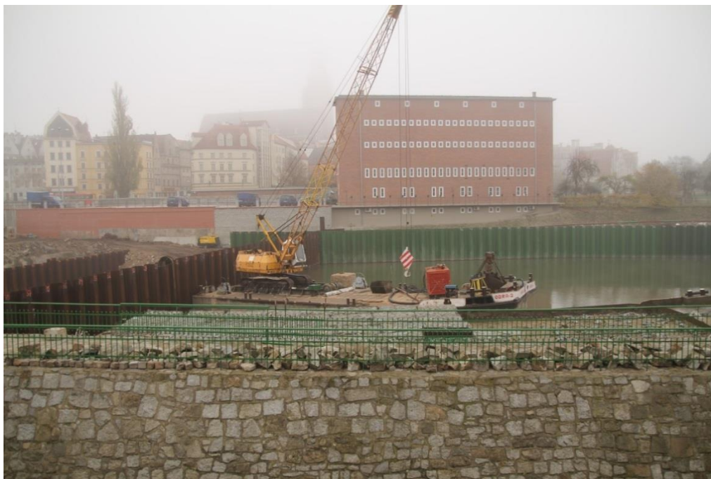
Rys. 4. Widok na Elektrownię Wrocław I i prace związane z przebudową jazu. Źródło: własne [listopad 2013]
