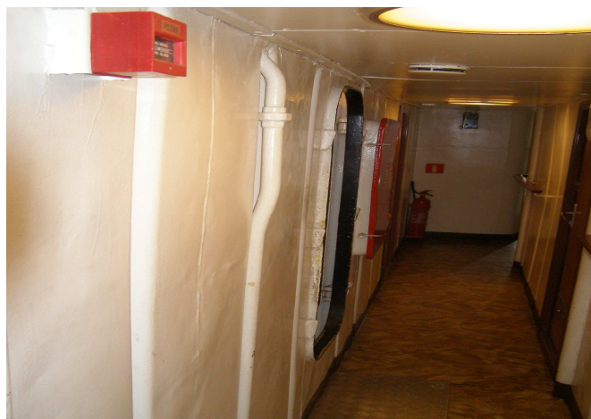
Fot. 7. Ograniczone przestrzenie należą do największych utrudnień podczas działań ratowniczo-gaśniczych na okrętach. Uwagę zwraca ograniczona przestrzeń teoretycznie najlepiej przeznaczonych do przemieszczania się po okręcie ciągów komunikacyjnych oraz znaczna liczba drzwi i włączów prowadzących do pomieszczeń o różnych gabarytach i przeznaczeniu
