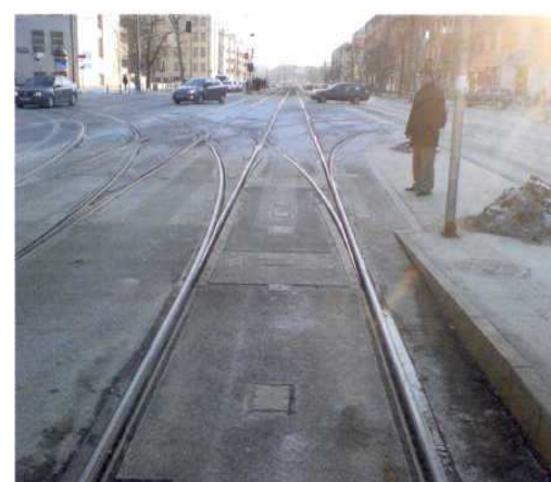
Rys. 4. Termogram i fotografia zwrotnicy tramwajowej wyposażonej w grzałki o mocy 1500 W, umieszczone przy opornicach (główkach szyn) półzwrotnic
