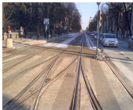
Rys. 3. Termogram i fotografia zwrotnicy tramwajowej wyposażonej w grzałki o mocy 1000 W, umieszczone przy opornicach (główkach szyn) półzwrotnic
