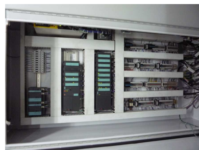
Rys. 5. Systemy kontrolujące prace skrzyń wodnych, rolek dociskowych oraz formera. Do bezpośredniego sterowania silnikami napędów rolek i formerów zostały użyte przekształtniki firmy VACON z serii NX.
