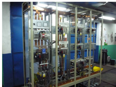
Rys. 5. Systemy kontrolujące prace skrzyń wodnych, rolek dociskowych oraz formera. Do bezpośredniego sterowania silnikami napędów rolek i formerów zostały użyte przekształtniki firmy VACON z serii NX.
