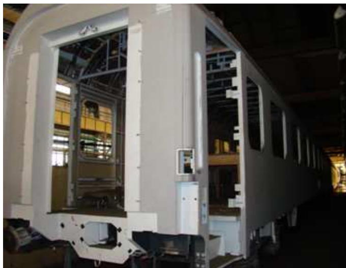
Rys. 7. Pudło wagonu kolejowego po zabiegu śrutowania, które zostało przygotowane do nałożenia kolejnych warstw i powłok. [fot. autora]
