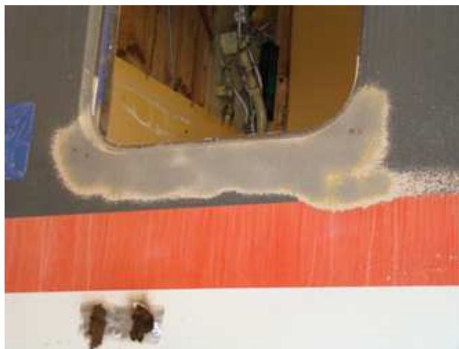
Rys. 9. Zregenerowane krawędzie otworu na okno pudła wagonu pasażerskiego. [fot. autora]
