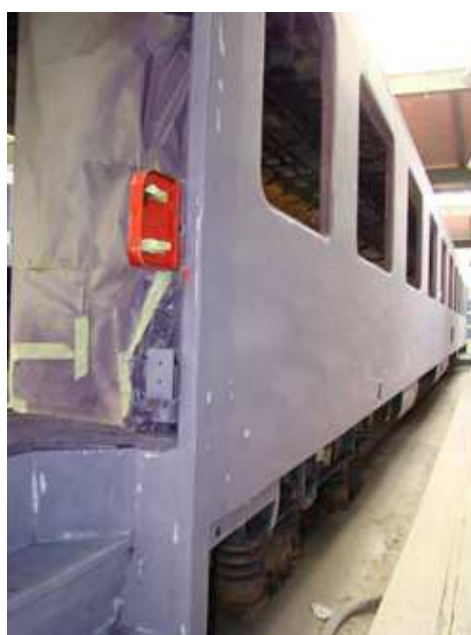
Rys. 8. Pudło wagonu kolejowego po nałożeniu warstwy szpachlowej przygotowanego do nałożenia warstw powłoki malarskiej. [fot. autora]
