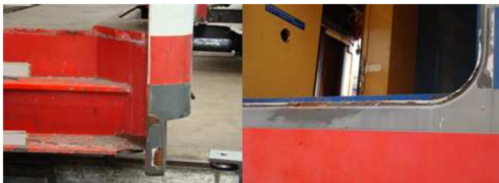
Rys. 2. Korozja pudła wagonu pasażerskiego DB w okolicy schód oraz framugi okiennej. [fot. autora]
