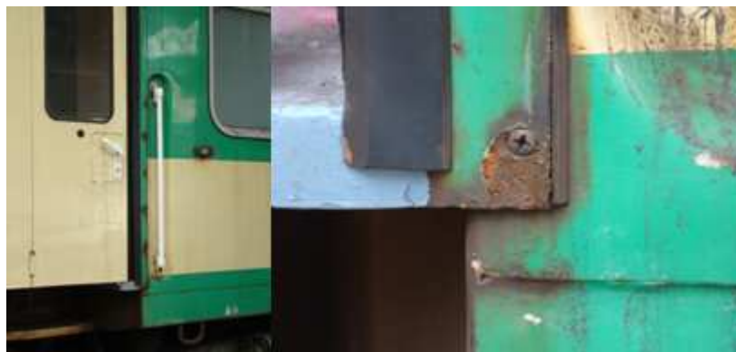
Rys. 3. Korozja pudła wagonu pasażerskiego PKP w miejscach łączeń w okolicach drzwi. [fot. autora]
