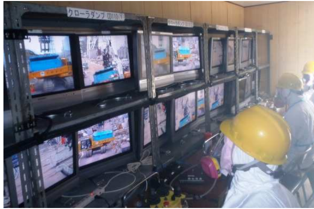
Rys.1. Centrum sterowania bezzałogowymi maszynami inżynieryjnymi podczas prac odgruzowywania reaktora atomowego w Fukushima
