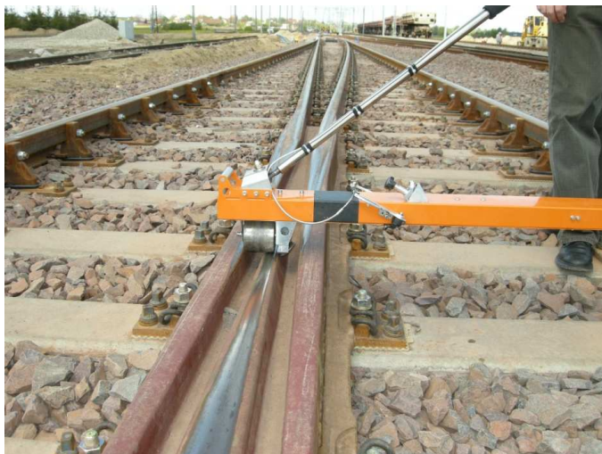
Fot. 5. Przejazd przez dziób krzyżownicy
