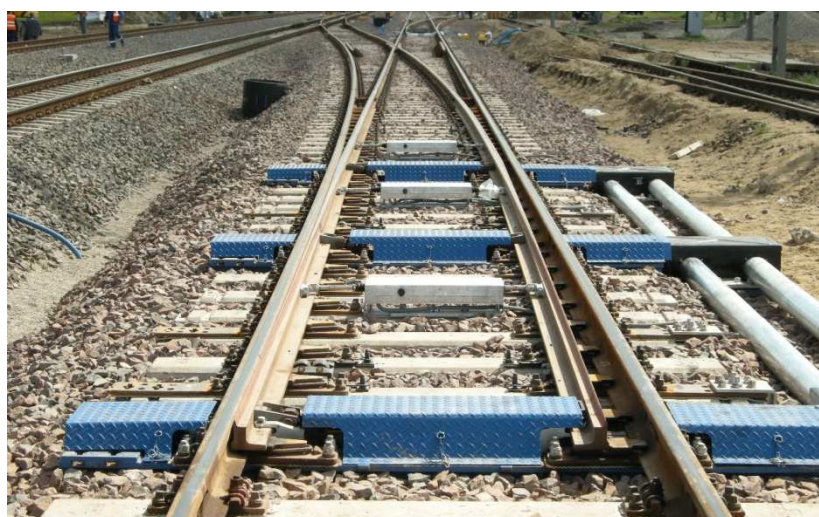
Fot. 2. Rozjazd zwyczajny lewy o promieniu 760 m
