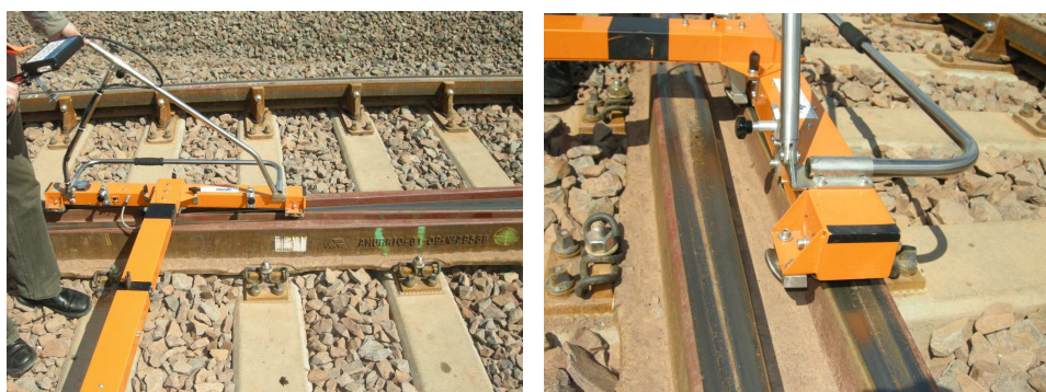
Fot. 8. Przejazd przez krzyżownicę w torze zwrotnym
