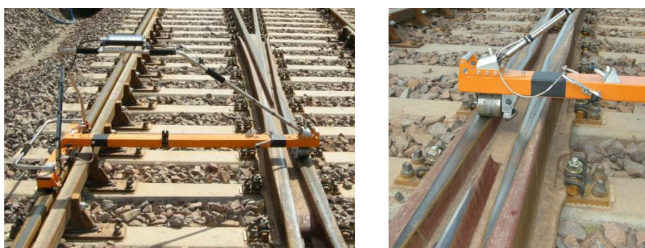
Fot. 4. Przejazd przez krzyżownicę – nieciągłość toku szynowego
