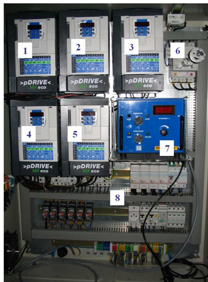
Fig.4. System pomiarowo-kontrolny zintegrowanego systemu rozdrabniania wielokrawędziowego PSOR-08; 1-5 – falowniki, 6 – moduł załączania, 7 – system sterowania zasilaniem nadawy do układu rozdrabniającego, 8 – system zabezpieczeń [1].
