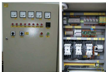
Rys. 5. Wygląd Zintegrowanej Tablicy Zasilającej w systemie SUZ-MONAT
