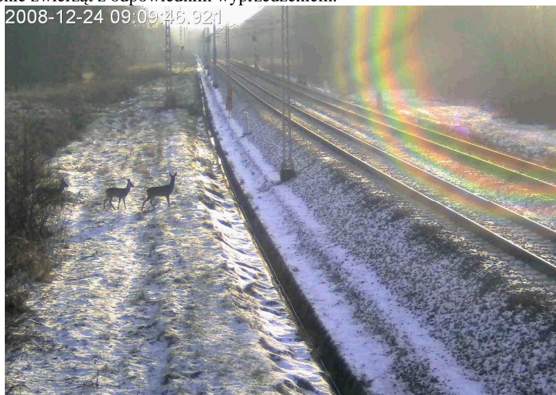
Fot.1. Widok z kamer monitoringu urządzeń UOZ-1 na linii E20
