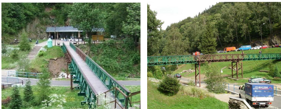
Rys.5. Kładka dla pieszych nad drogą w miejscowości Walim
