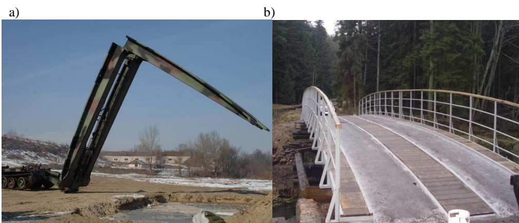
Rys.8. Przykład zaadoptowania przęsła mostu towarzyszącego BLG-67 o długości 20m i nosności do ruchu pojazdów cywilnych, w m. Kletno gm. Stronie Śląskie, potok Kleśnica: a) BLG-67 w fazie rozkładania, b) adaptacja przęsła
