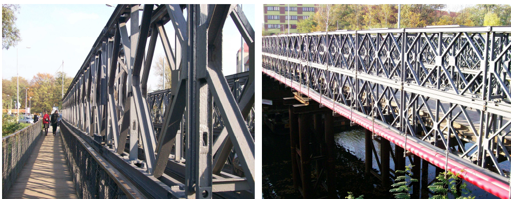
Rys.7. Most tymczasowy we Wrocławiu zbudowany na czas remontu Mostu Szczytnickiego
