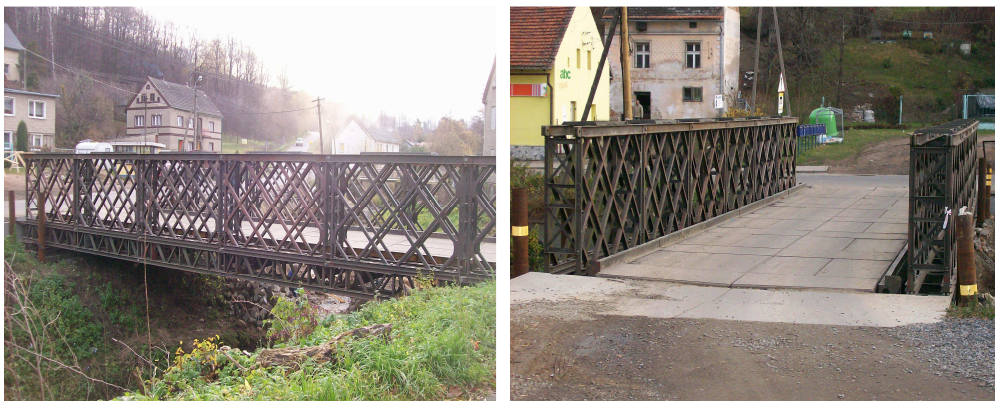
Rys.6. Most tymczasowy na rzece Potok Długosza w miejscowości Gieraltce k. Głucholaz
