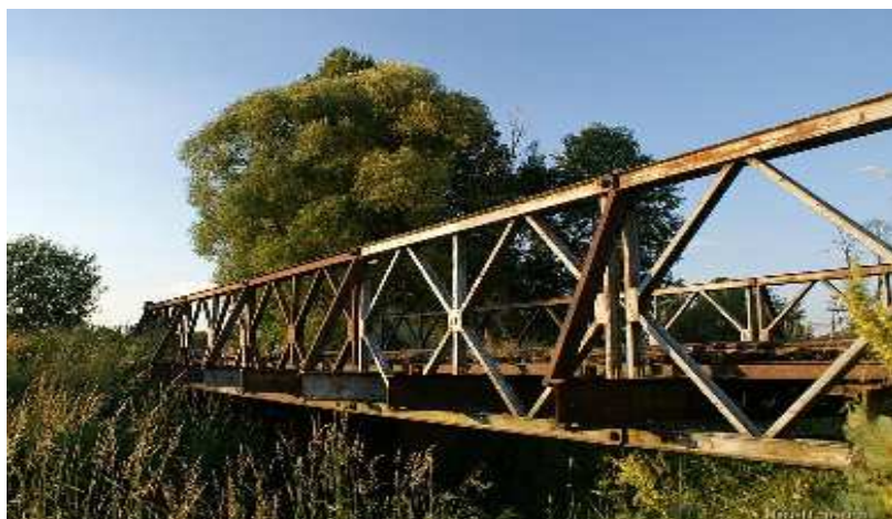
Rys. 2. Most MS 22-80 (Bailey'a) na rzece Czarnej w Izabelinie, gm. Nieporęt
