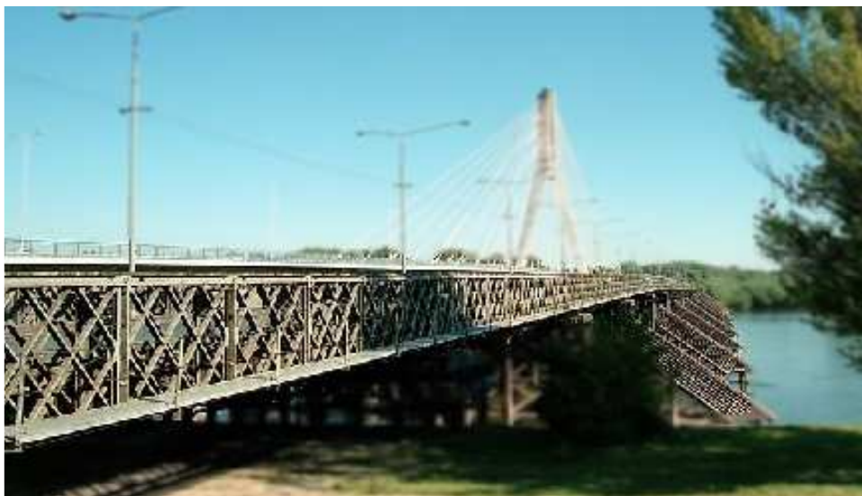
Rys. 1. Most Syreny w Warszawie, wykonany jako konstrukcja MS-54
