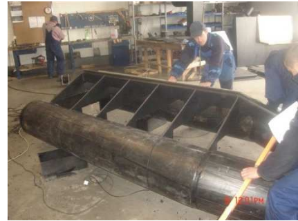
Rys. 11: WORKER w fazie budowy.
