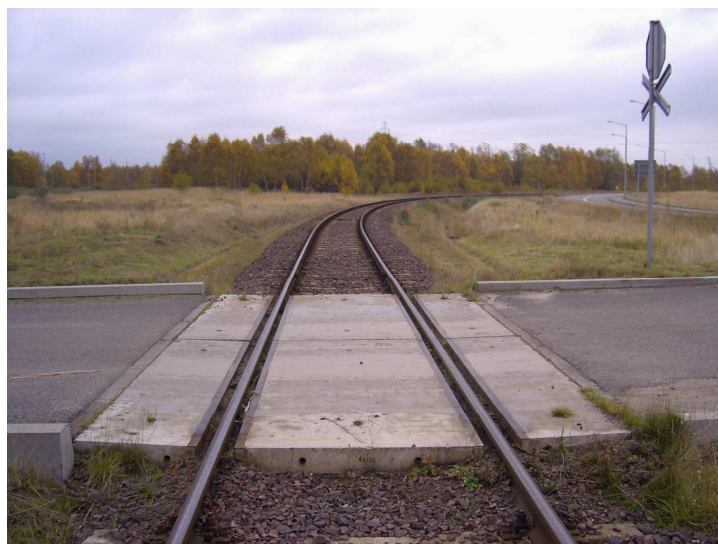
Rys. 2. Widok przejazdu kolejowego na skrzyżowaniu z drogą kołową
