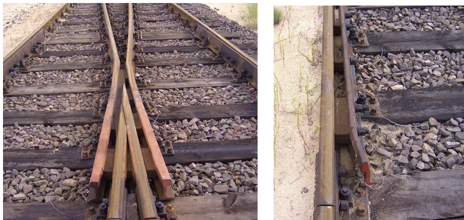
Rys.4. Widok na krzyżownicę (z lewej) i kierownicę (z prawej)
