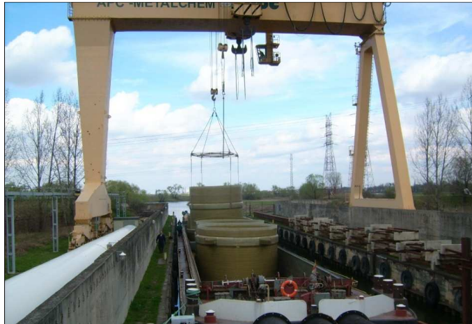
Rys. 7. Rozładunek wkładów kominowych
