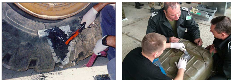
Rys. 1. Przykłady napraw z wykorzystaniem kompozytów klejowych.
