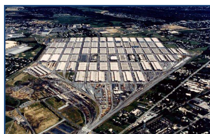
Rys.2. Współczesne magazyny brzegowe wraz z infrastrukturą
