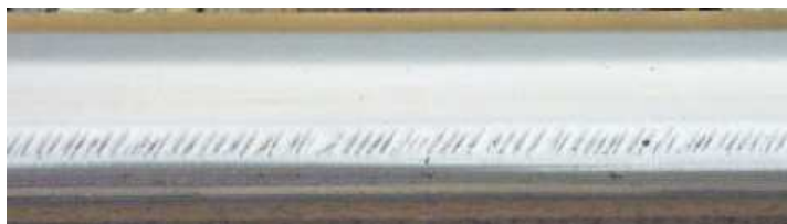
Rys. 4. Pęknięcia head checks
