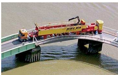
Rys.3. Pojazd BELFA w trakcie badania przęsta
