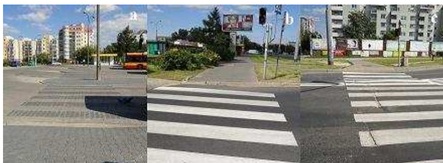
Rys. 5.6 Dojście do przystanku: a). prawidłowe jednopoziomowe przejście dla pieszych na terenie pętli autobusowej; b). przejście przesiadkowe nieprawidłowe z jednej strony znajduje się pochylnia z drugiej - wysoki krawężnik; c). przejście przeznaczone do wejścia na pętlę autobusową - wysoki krawężnik
