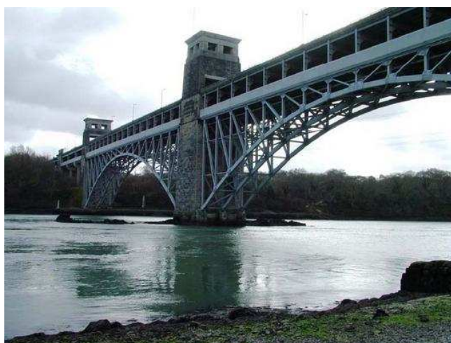
Rys. 1. Widok na most Britannia, [7]
