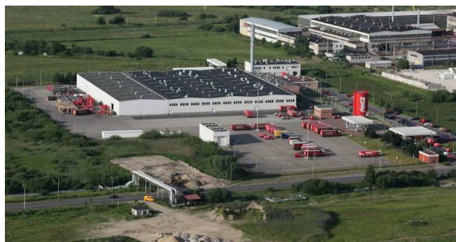
Rysunek 13 Gdynińskie centra logistyczne: Firma Coca-Cola usytuowane przy ul. Hutniczej
