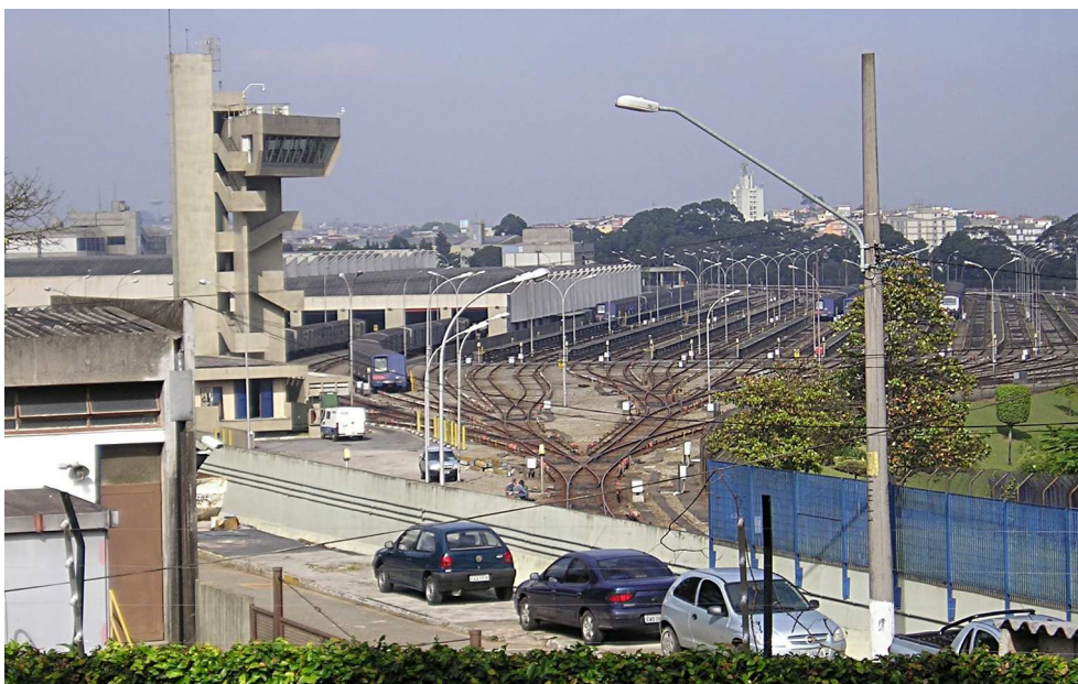
Rys.4. Stacja postojowa przy terminalu Jabaquara (fot. M.J. Nowakowski)
