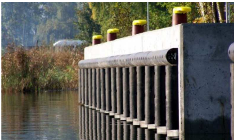
Rys.4. Zastosowanie belek odbojowych na nabrzeżu
