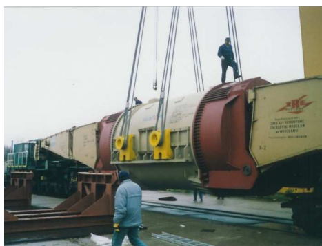
Rys.4. Rozładunek z wagonu typu NORCA generatora o ciężarze 330 ton przez firmę Metalchem Serwis Sp. z o. o. [9]
