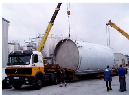
Rys.1. Rozładunek zbiornika 1100 m 3 [4]
