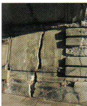
Rys. 1. Wiadukt na ul. Karowej [1]
