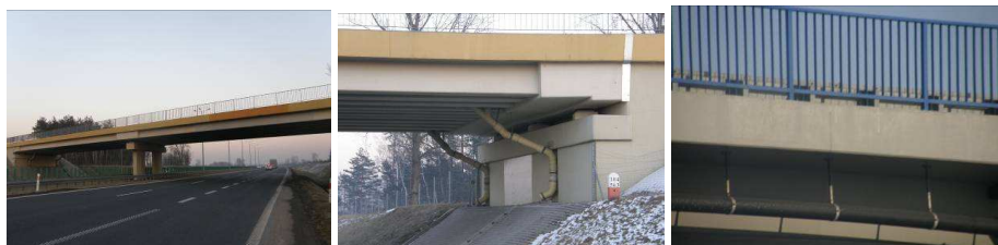
Rys. 8. Przykład sposobu odwodnienia wiaduktów
