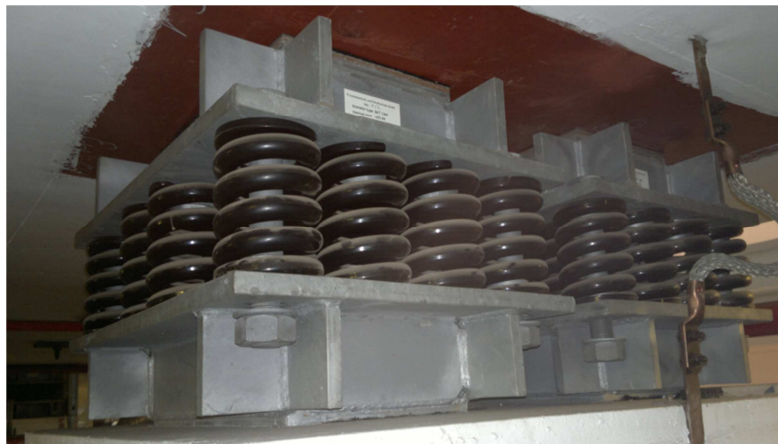
Rys.3. Widok pakietu wibroizolacji dla jednego ze słupów
