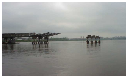
Fot. 1 Drogowy Most Składany DMS – 65 w trakcie budowy
