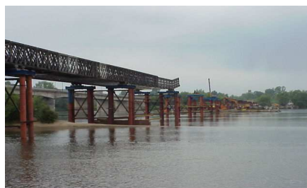
Fot. 2 Konstrukcja MS – 54 w trakcie budowy
