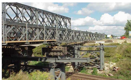
Fot. 3 Most MS-22-80 podczas nasuwania
