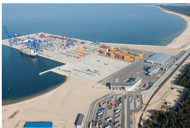
Rys. 2 Budowa DCT od 2005-2007 r.
