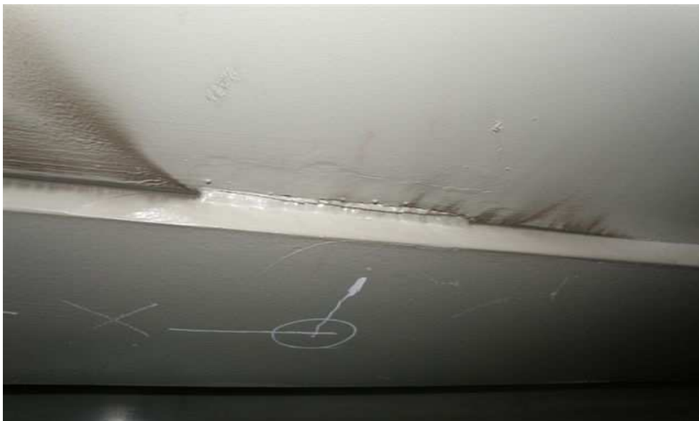
Rys.8. Uszkodzenie pokrywy dolnej generatora energetycznego
