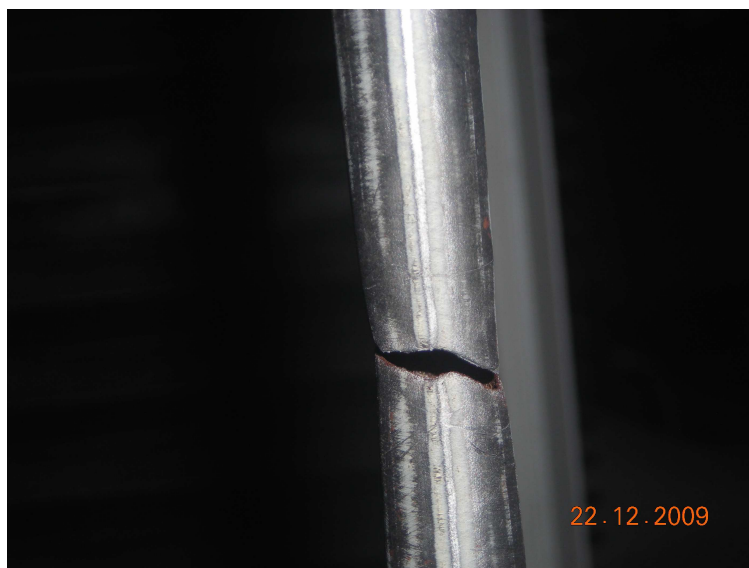
Rys. 4. Widok próbki skorodowanej w kwasie siarkowym po wykonaniu badań wytrzymałościowych
