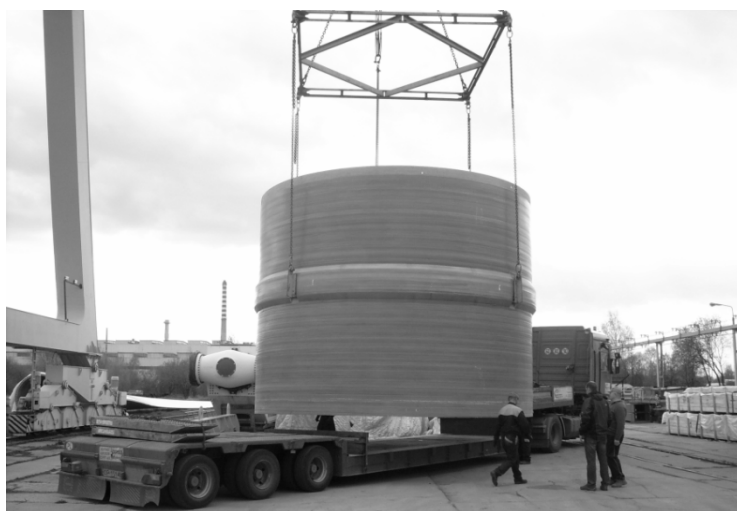
Rys. 2. Wkład kominowy w trakcie przeładunku
