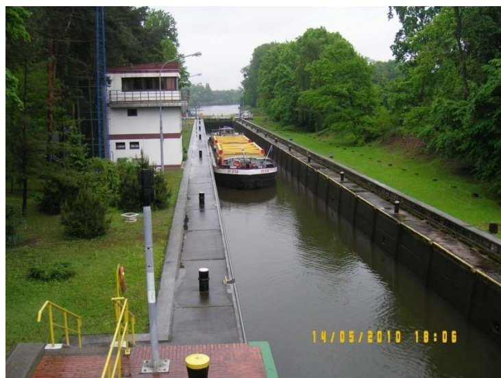
Rycina 3. Umocnione nabrzeża śluzy (Śluza Zacisze, Węzeł Wrocławski).
