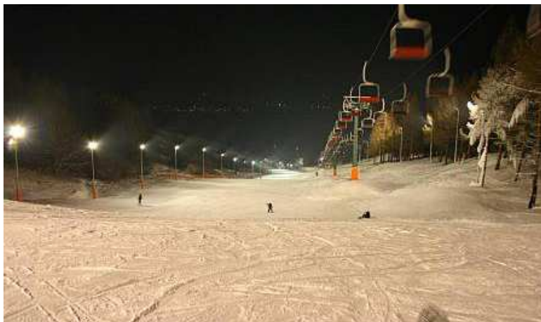
Rys.3. Oświetlenie stoku narciarskiego.
