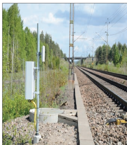
Fot. 1. Czytniki znaczników EPC/RFID obok torów kolejowych.
