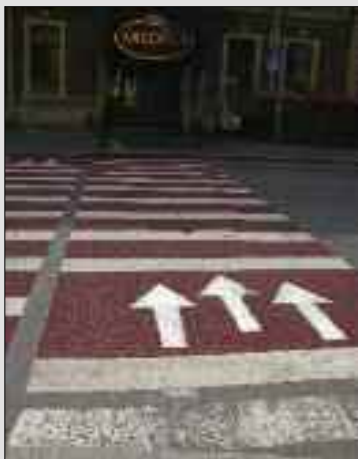
Fot. 5. Wyznaczenie kierunku przechodzenia przez przejście zmniejsza kolizyjność (fot. Autor).
