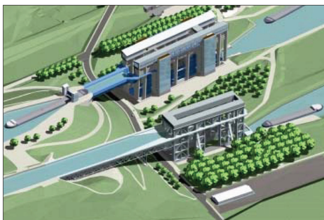
Rys. 4. Makieta przedstawiająca istniejącą i nową, budowaną obecnie podnośnię dla statków Niederfinow. Źródło: www.wse.eberswalde.de
