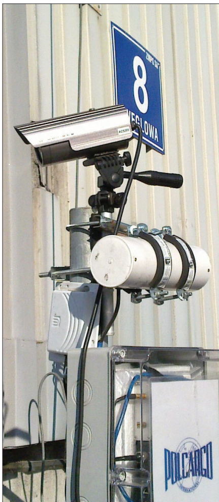
Fot. 3. Czytnik do aktywnej technologii RFID przy wjeździe do magazynu (fot. własność Polcargo).
