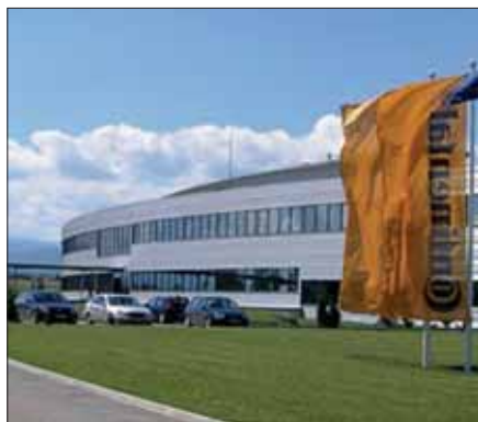
Rys. 7. Widok centrum logistycznego Shanghai Regional Distribution Center. Źródło: http://www.otr.pl/index.php?option=com_content&task=view&id=558&Itemid=56
