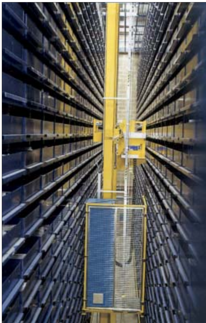
Ryc. 1. Widok automatycznej układnicy w głębi korytarza regałowego usługowego centrum gromadzenia dokumentów
