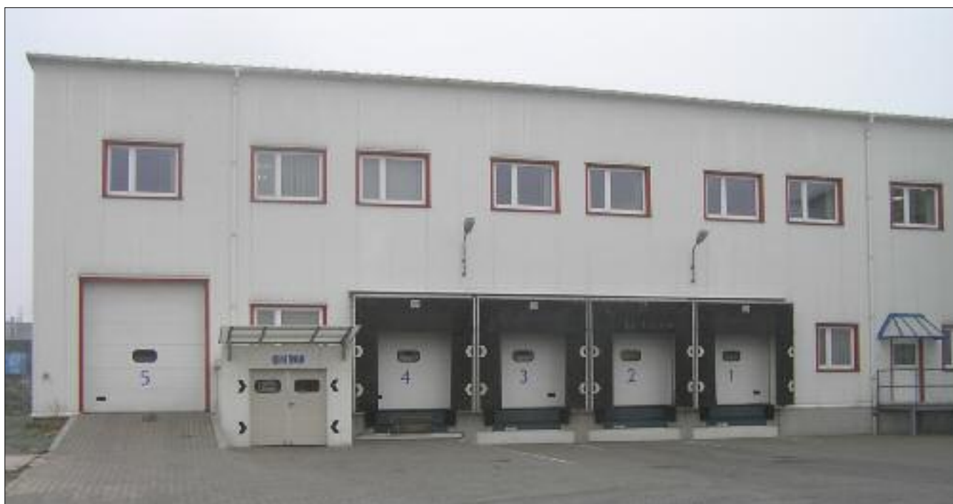
Fot. 1. Przykład obiektu magazynowego – widok z zewnątrz (fot. A. Wojciechowski).
