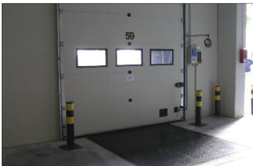
Fot. 2. Stanowisko przeładunkowe z bramą segmentową oraz mostkiem ładunkowym napędzanym (fot. A. Wojciechowski).
